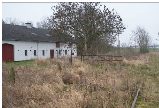
Figur 47 - større gård med ledsikret overkørsel.
