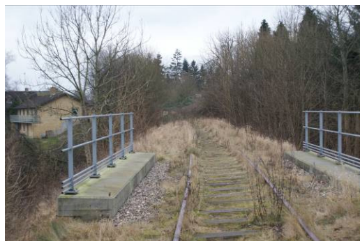
Figur 63 – broen over ”Viadukten”.
