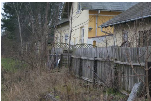
Figur 42 - Højrup station set fra sporet.
