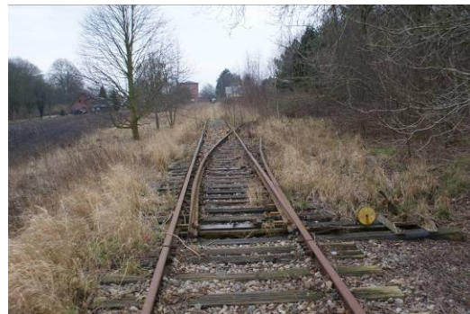
Figur 37 - Intakt aflåst sporskifte nord for Højrup.
