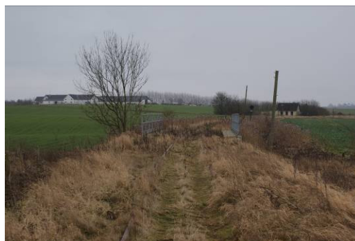
Figur 49 - Nyere bro over å passeres.
